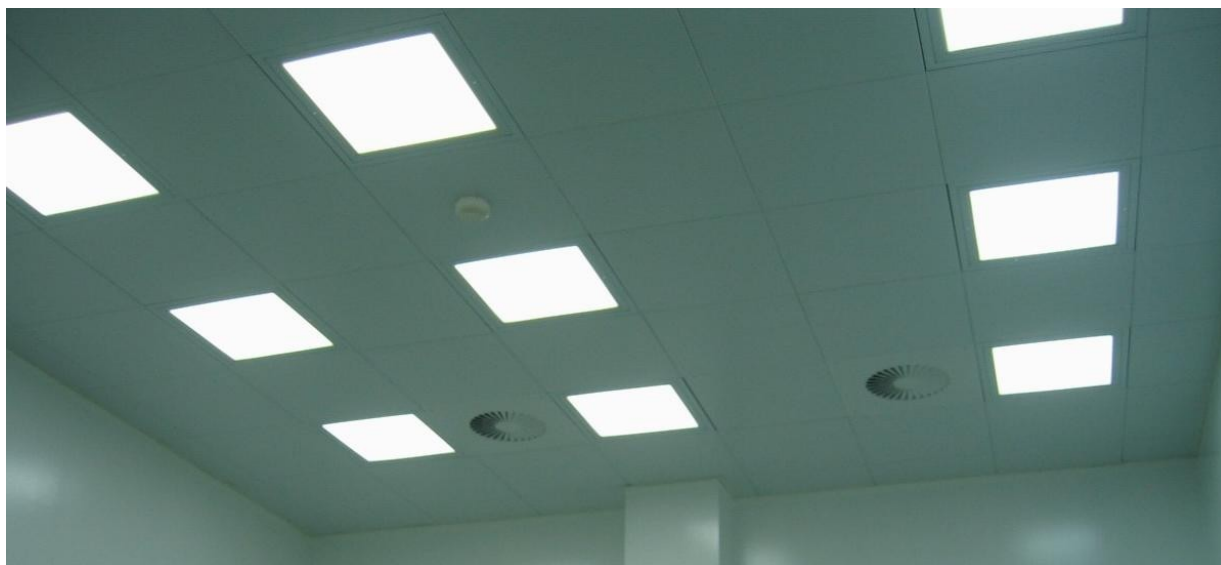
Zdj. Zabudowa pomieszczeń
