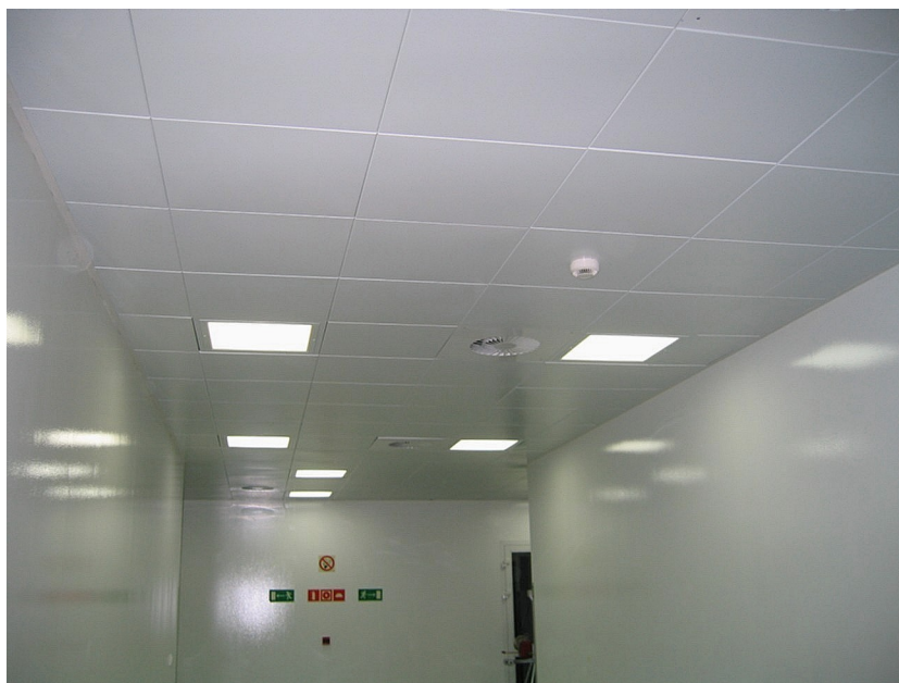
Zdj. Zabudowa korytarza
